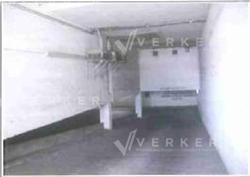
FOTO 1 RAMPA DE ACCESO A ESTACIONAMIENTO
